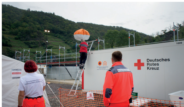
Unsere Einsatzkräfte beim Aufbau der Kläranlage (Ahrtal, 2021)
